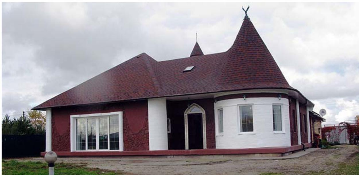
**Рис. 4.** Жилой дом, построенный с помощью технологии строительной 3D-печати, г. Ярославль, Россия<sup>1</sup>
